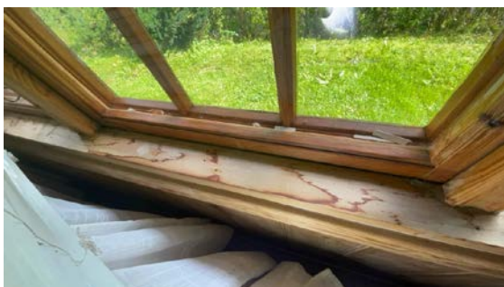
Løst kitt imellom glass
