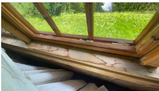
Løst kitt mellom glass
