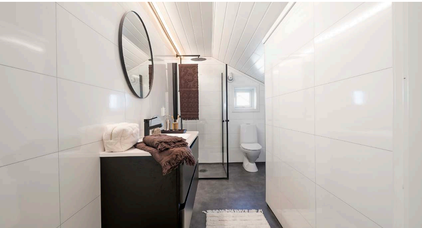
Skråhimling i 2. etasje.
