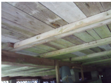
Deler av underliggende stubbloft.
