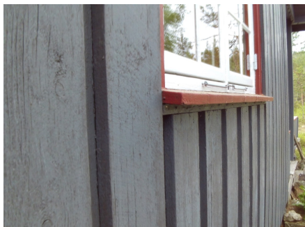
Deler av kledningen med tilhørende belistninger
