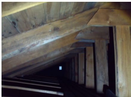
Deler av takkonstruksjonen.
