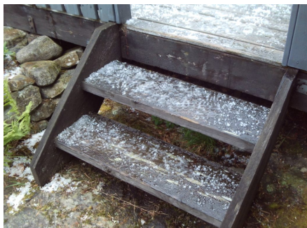
Ene trappen til terrasse.
