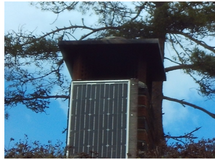
Bunnbeslag på pipe over tak.
