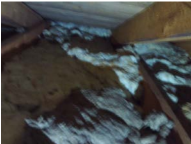
Ingen/lite tilgang på luft ved takutstikk
