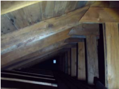
Deler av takkonstruksjonen.
