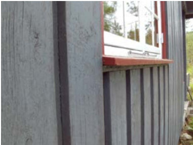
Deler av kledningen med tilhørende belistninger
