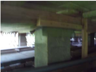
Pilarer av leca med tilhørende dragere.
