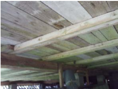
Deler av underliggende stubbloft.
