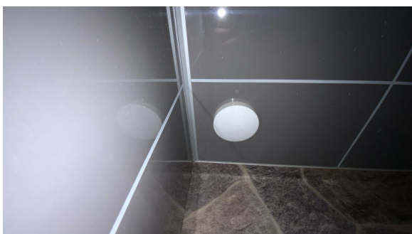
Løsning for å synliggjøre lekkasje fra vannskap.
