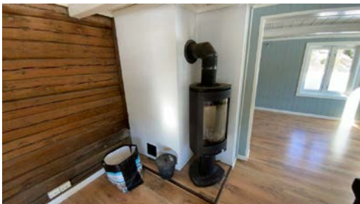
Montert peisov i 1. Etasje
