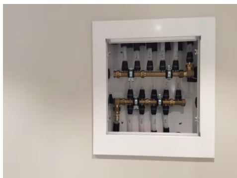
Nytt røropplegg i leiligheten.
