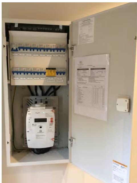
Komplett nytt elektrisk anlegg i leiligheten.
