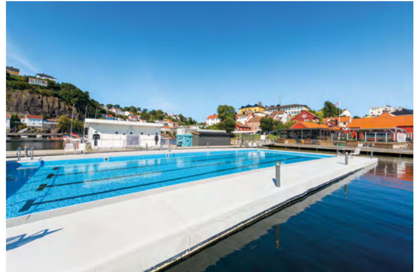
Fra Arendal gjestehavn med svømmebasseng og restaurant i vannkanten.
