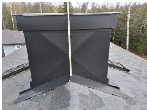
Pipehøyden er målt til ca 60 cm.
