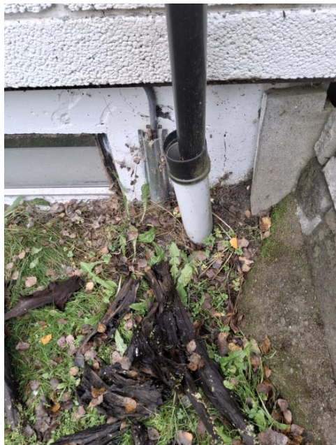
Taknedløp er ført til lukket rør.
