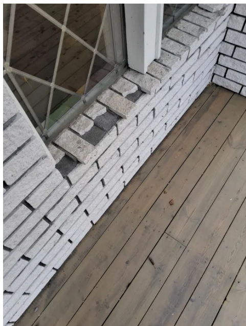
Det mangler stedvis forblendingsstein.
