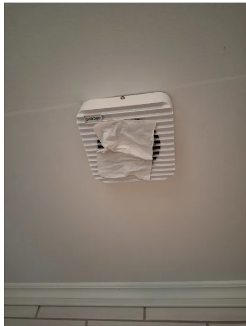
Avtrekkseffekten er testet med papir.
