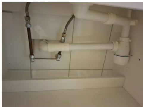
Boligen har synlige avløpsrør i plast.
