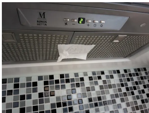
Avtrekkseffekten er testet med papir.
