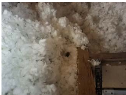
Det registreres tegn til aktivitet fra gnagere i løsisolasjon.
