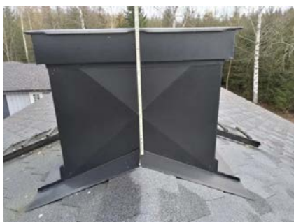
Pipehøyden er målt til ca 60 cm.
