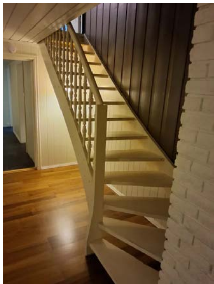
Åpen tretrapp mellom etasjene.
