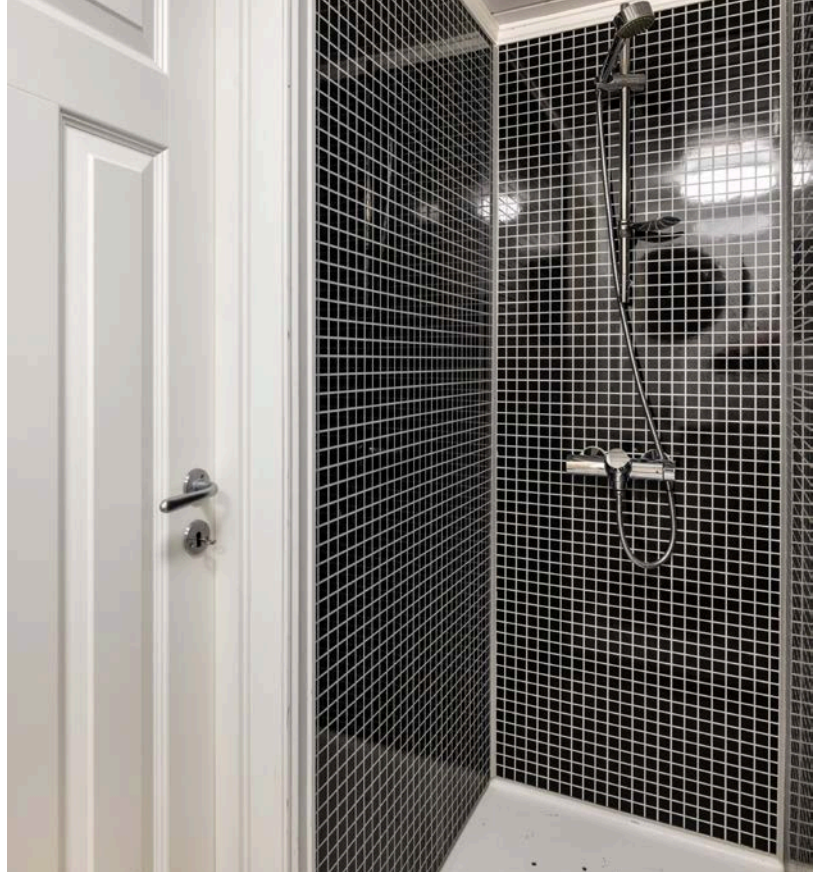
Dusjnise med vegghengt dusjbatteri.
