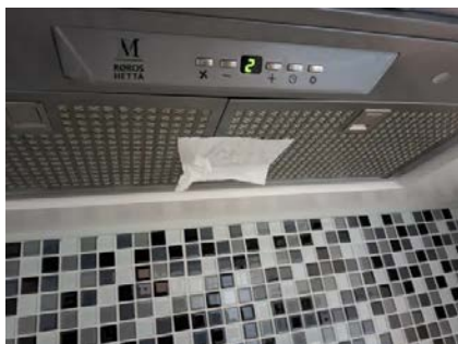
Avtrekkseffekten er testet med papir.
