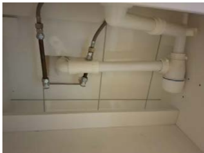
Boligen har synlige avløpsrør i plast.
