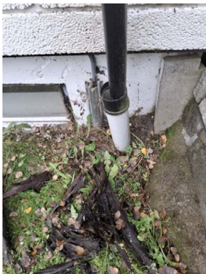
Taknedløp er ført til lukket rør.
