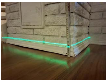
Etasjeskiller er kontrollert med nivelleringslaser.
