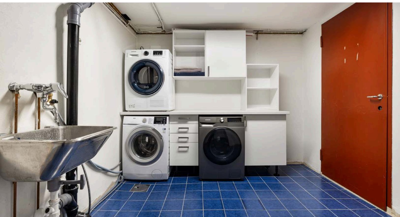
Romslig vaskerom i kjeller med utslagsvask, innredning og opplegg for vaskemaskin og tørketrommel.
