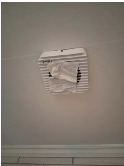
Avtrekkseffekten er testet med papir.
