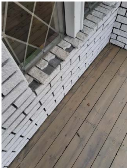
Det mangler stedvis forblendingsstein.
