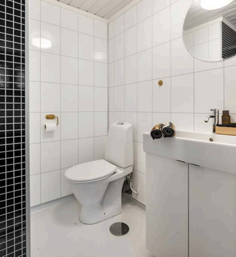
Bad i kjeller med gulvmontert toalett og servantskap med heldekkende servant.
