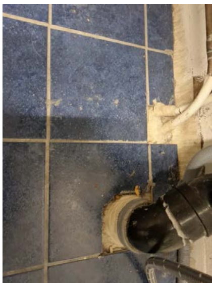
Fliser er lagt på eksisterende gulvbelegg.
