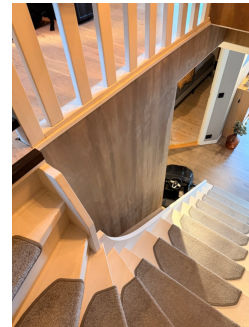
Det mangler håndløper på vegg i det innvendige trappeløpet.
