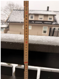
Rekkverket er for lavt i forhold til dagens krav.
