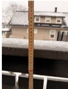
Rekkverket er for lavt i forhold til dagens krav.
