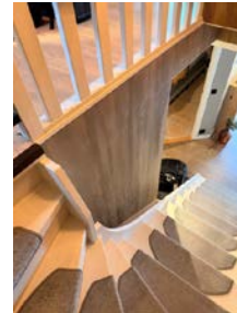
Det mangler håndløper på vegg i det innvendige trappeløpet.
