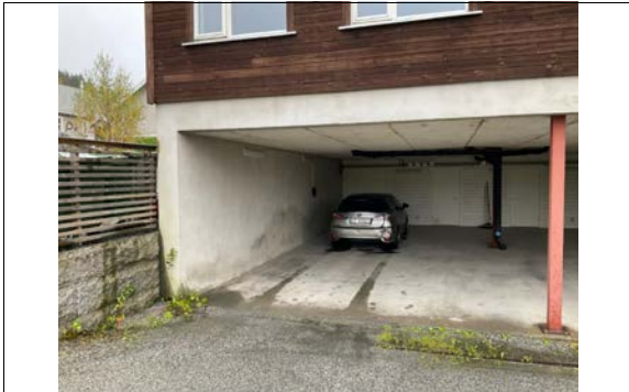
Åpen underetasje med biloppstillingsplasser og sportsbod.
