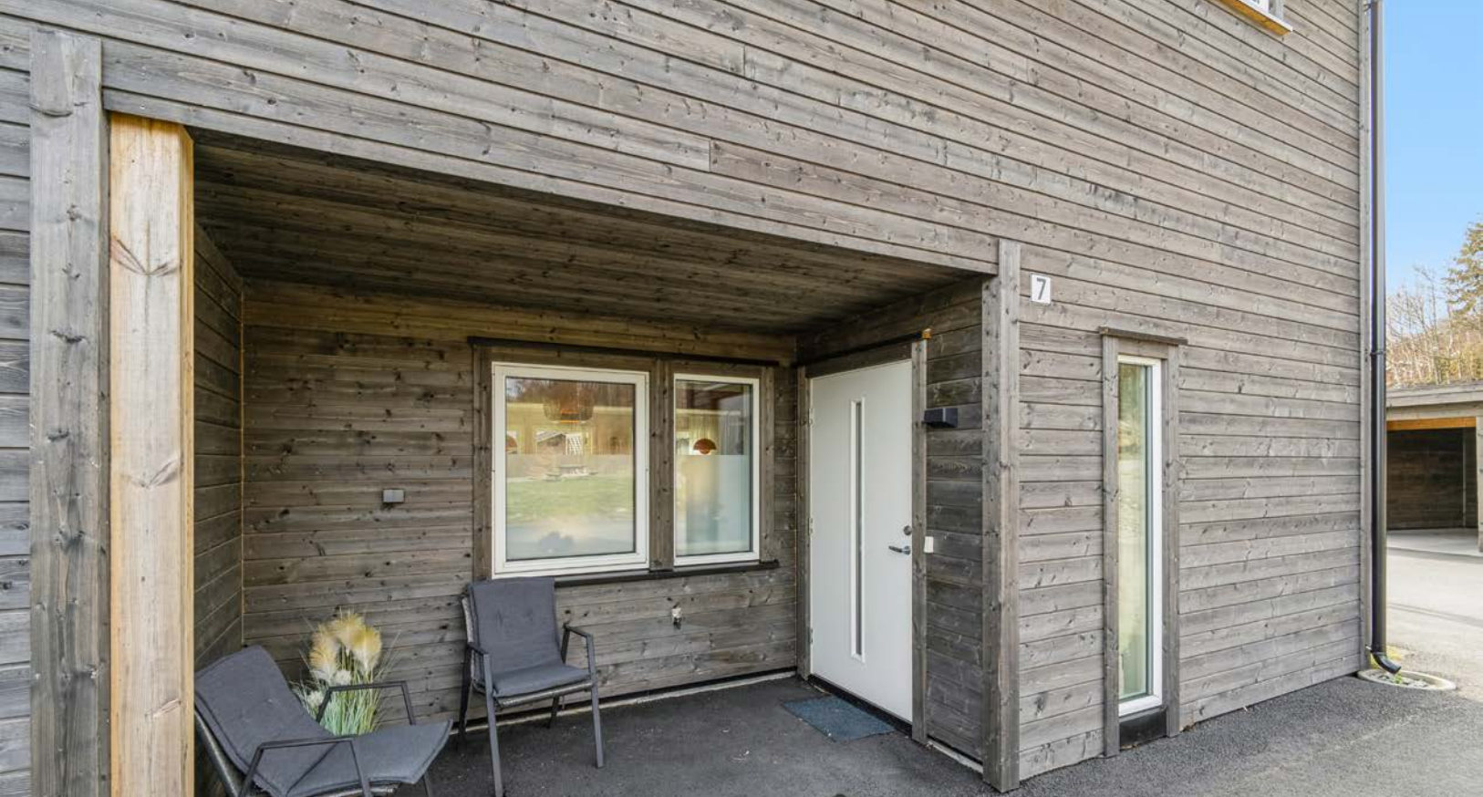
Overbygget uteplass ved inngangspartiet
