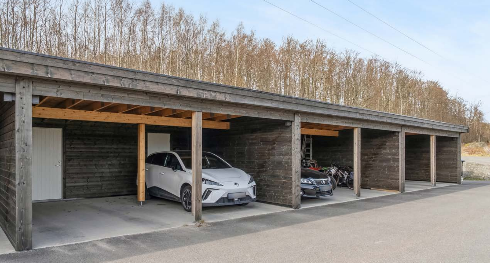
Carport med elbillader samt sportsbod tilhører boligen
