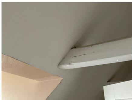
Bjelke-gjennomføring i tak
