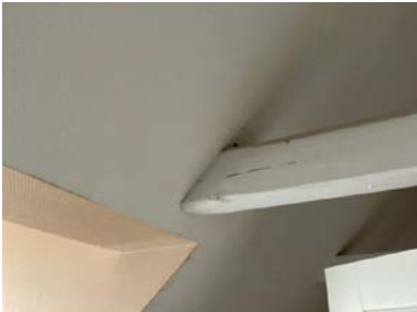
Bjelke-gjennomføring i tak
