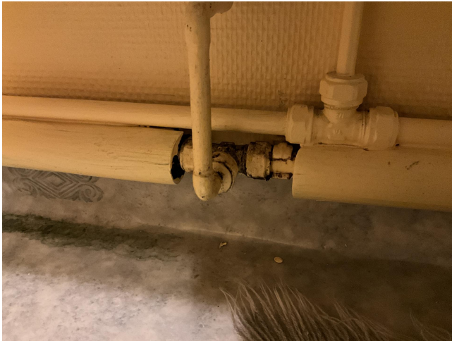
Vann- og avløpsrør er fra 2010 Ingen dokumentasjon tilgjengelig.
