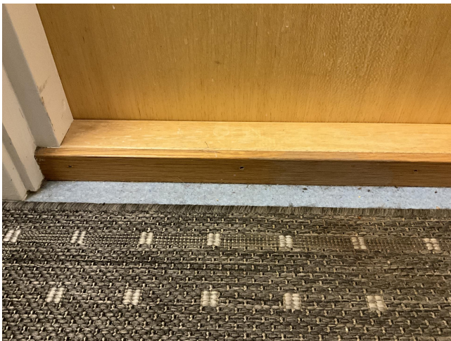
Det mangler gjennomstrømning av luft i toalettrom.
