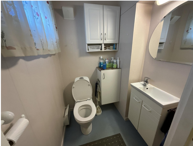
Eldre sanitærutstyr og innredning.
