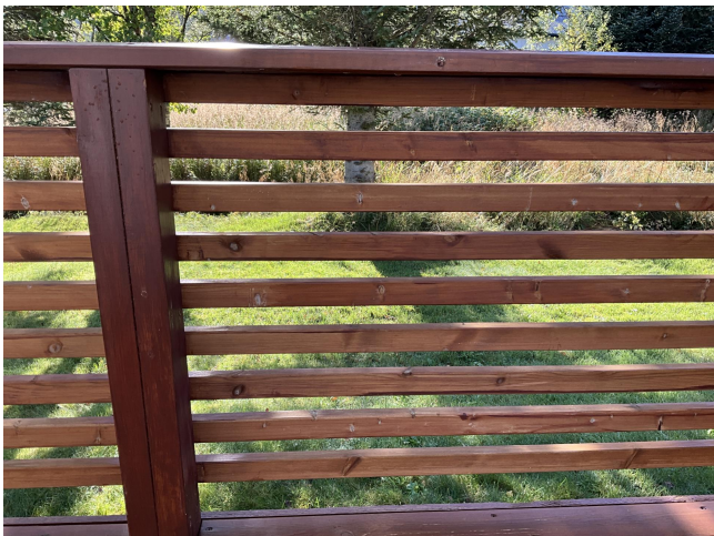
Rekkverket har horisontale spiler eller utforming som gjør det klatrevennlig.
