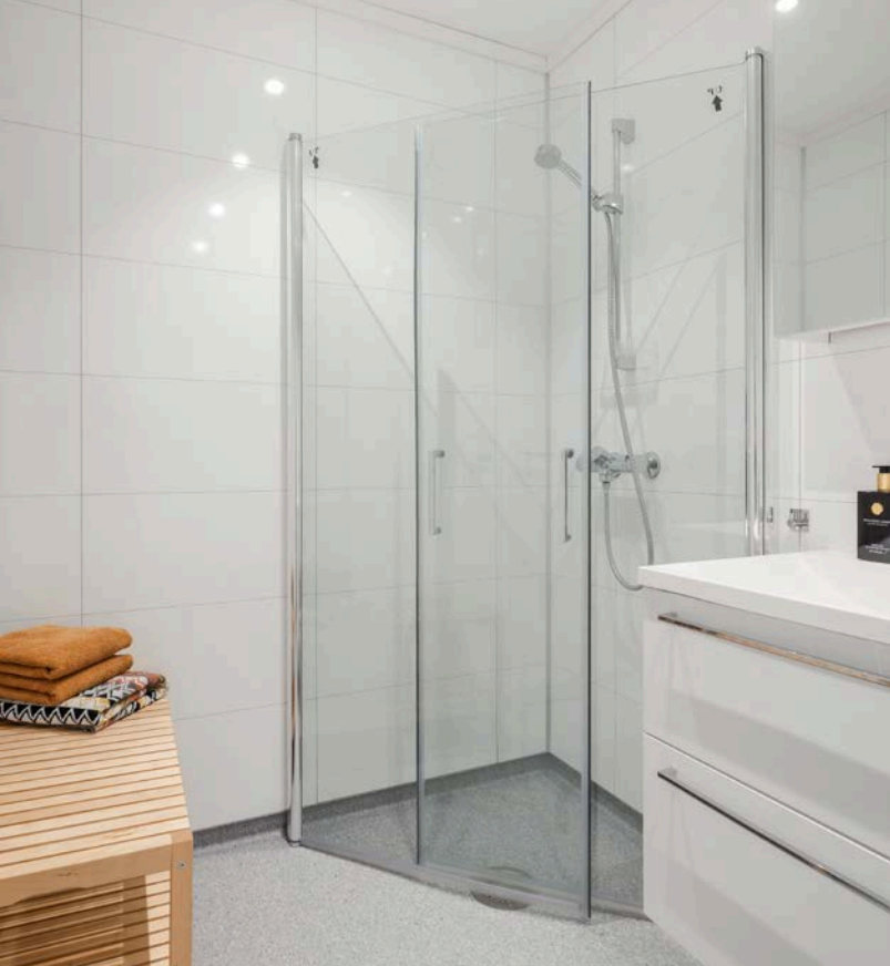
Badet er utstyrt med dusjhjørne med innfellbare dusjdører og vegghengt dusjbatteri.
