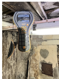
Målt i gulvbjelke midt i kjelleren.
