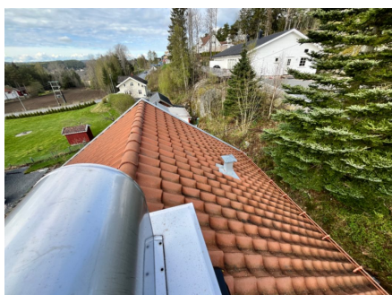
Kloakklufting over tak
