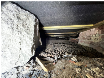
Bilde tatt fra luke i vegg i kjeller.
