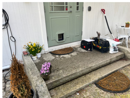
Kledningen er montert ned under overkant av trappen.
