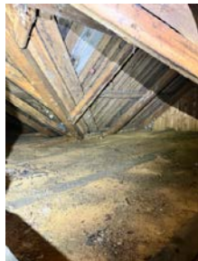
Fuktkontroll ved pipe som er i bruk
