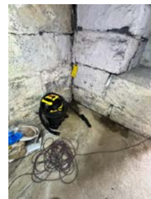
Noe vann innsig i sørøstre hjørne på kjeller.
