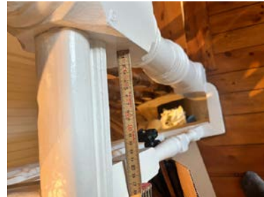
Store åpninger i rekkverket.
