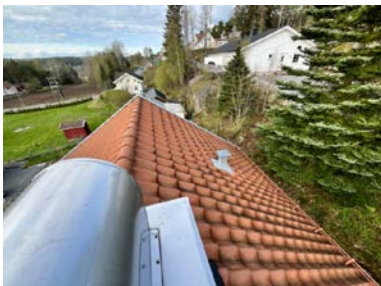
Kloakklufting over tak
