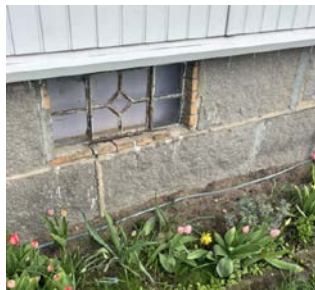
Noe løsnet stein rundt vindu, noen fuger er utbedret.
