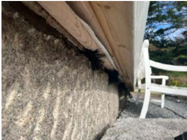
Det er ikke laget lufting i nedkant på vegg på sør og vestvegg.
