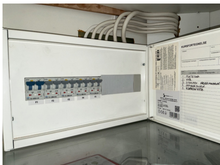
Automatsikringer i sikringsskap plassert inne i overskap på kjøkkenet.
