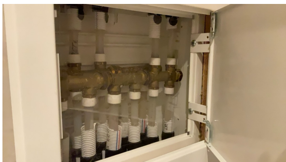
skap i underetasje.
