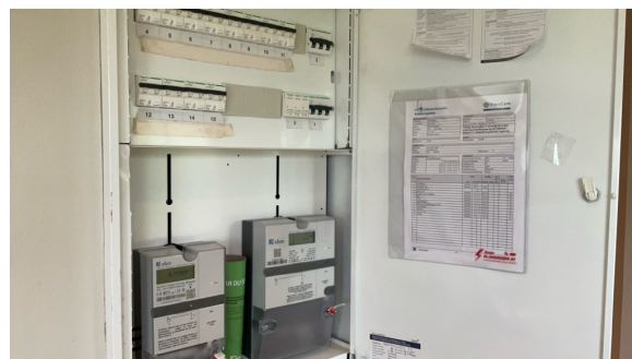
skap i underetasje
