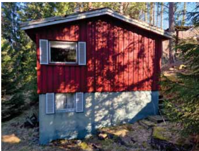
Gavlvegg mot vest
