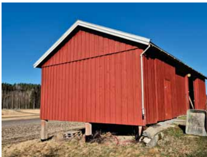
Gavlvegg mot sør
