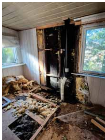
Råteskade innvendig
