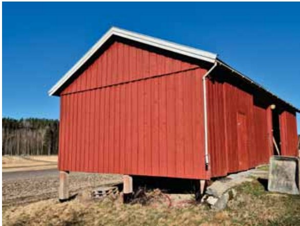
Gavlvegg mot sør
