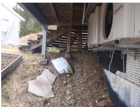
Provisorisk understøttelse og fundamentering
