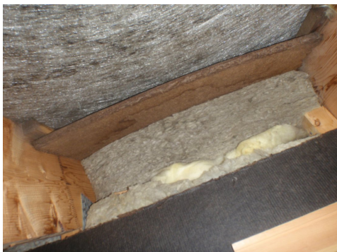
Liten luftespalte, luftespalten bør være over 5 cm.
