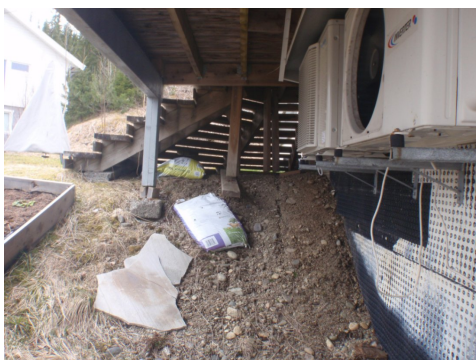
Provisorisk understøttelse/fundamentering for trapp og balkong.
