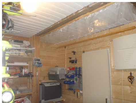
Rester etter tidligere kjøleromsvegger.
