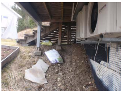
Provisorisk understøttelse/fundamentering for trapp og balkong.
