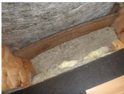
Liten luftespalte, luftespalten bør være over 5 cm.
