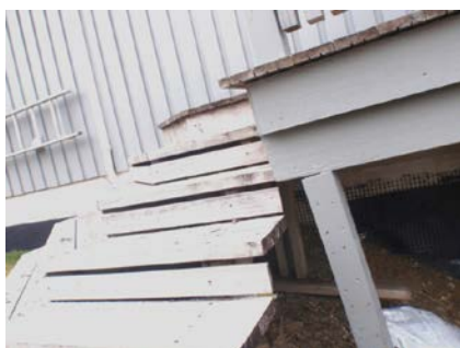
Provisorisk understøttelse og fundamentering
