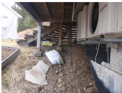
Provisorisk understøttelse og fundamentering
