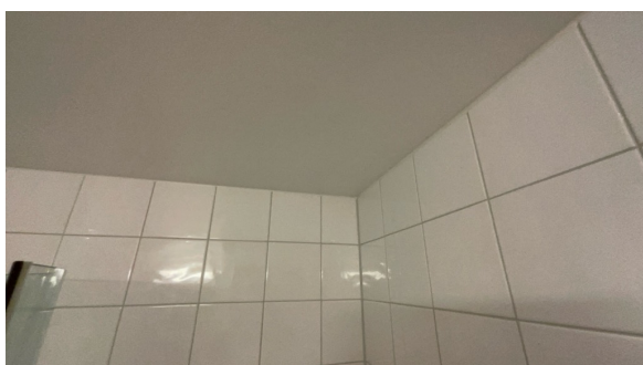
Del av vegg - tak.
