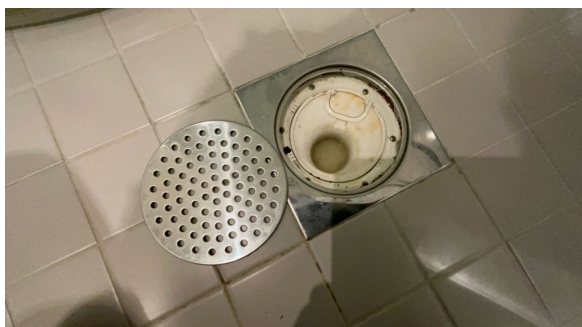
Sluk i gulv.
