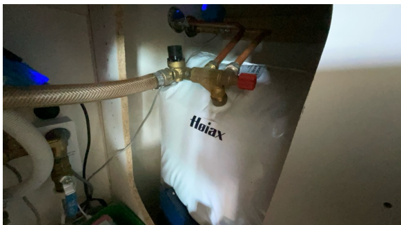
Varmtvannstank i kjøkkenbenk.
