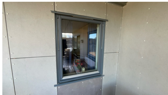
Eksempel på vindu i yttervegg.
