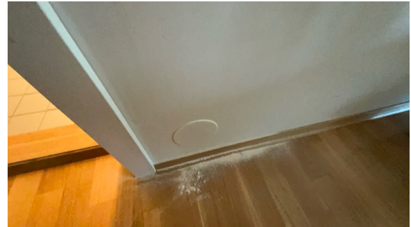
Lokk over hull.
