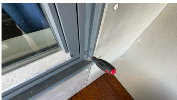
Stikk kontroll på vinduer er utført.
