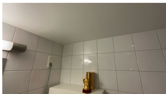
Del av vegg - tak.
