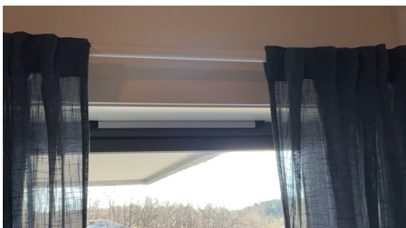
Eksempel på montert ventil i vindu.
