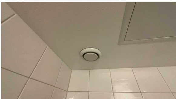
Montert avtrekk i tak.
