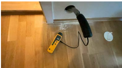
Hull for kontroll av fukt.
