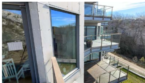
Eksempel på vindu i yttervegg.
