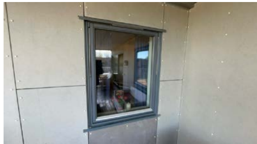
Eksempel på vindu i yttervegg.
