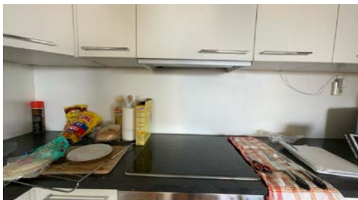
Montert avtrekk over steketopp.
