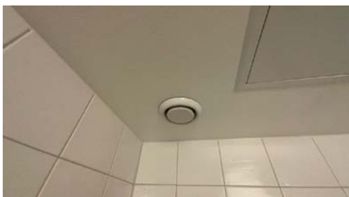
Montert avtrekk i tak.
