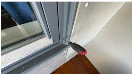
Stikk kontroll på vinduer er utført.
