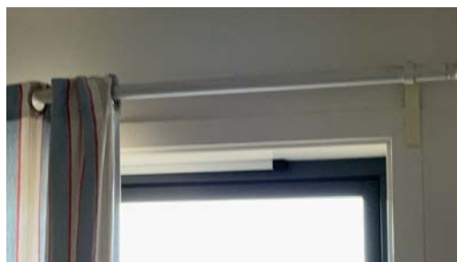
Eksempel på montert ventil i vindu.
