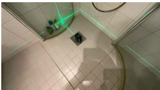
Målt fall på gulv. Del av gulv.
