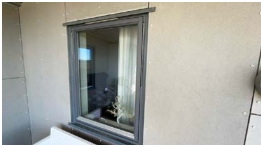
Eksempel på vindu i yttervegg.
