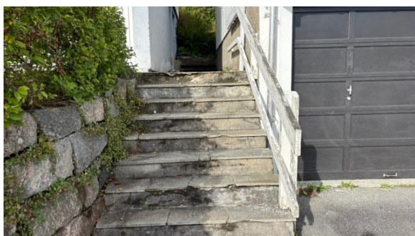
Betongtrapp på sørsiden
