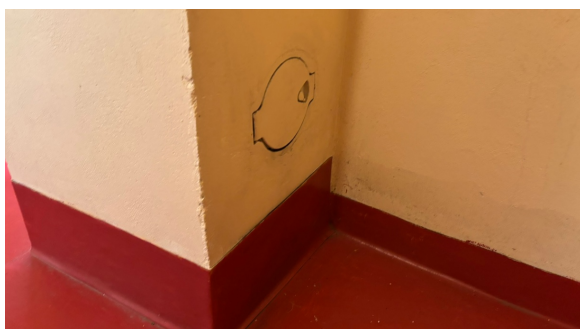
Sotluken er plassert på badet i kjelleren
