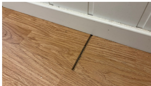
Endeskjøt på laminatgulvet har sklidd fra hverandre.
