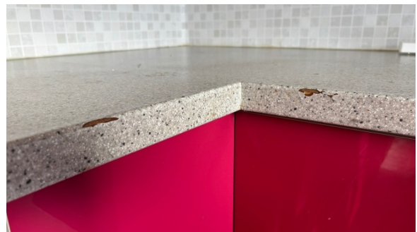
Skader på benkeplaten
