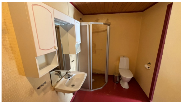
Oversiktsbilde av badet
