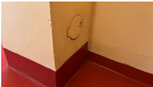
Sotluken er plassert på badet i kjelleren
