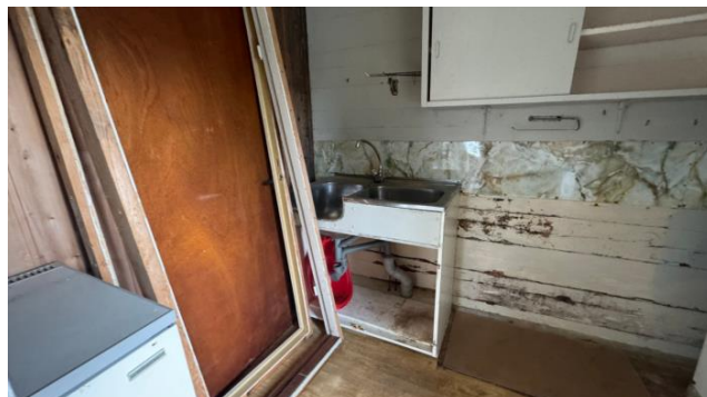
Bilde viser deler av kjøkkeninnredningen
