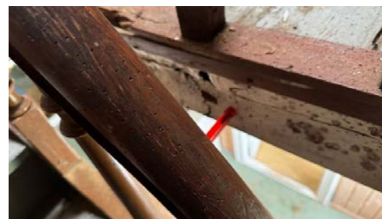
Bilde viser flatt skrujern som ble skyvd helt inn i råteskadet trebjelke i etasjeskillet.
