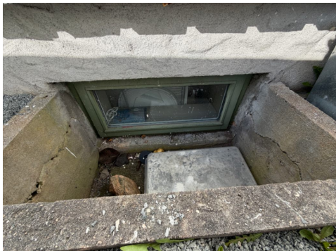
Vindu på vaskerom
