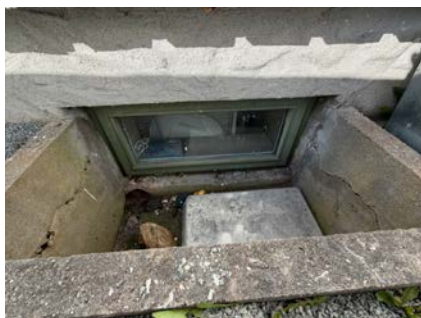
Vindu på vaskerom
