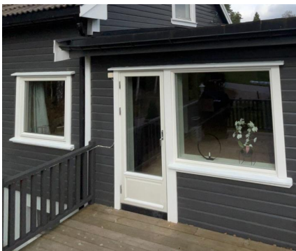
Ytterdør mot underetasje.
