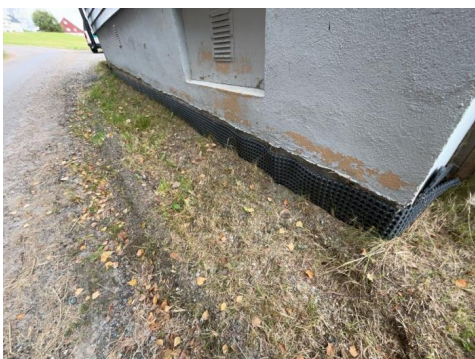
Utsnitt fuksikring av grunnmur.
