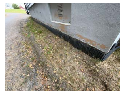
Utsnitt fuktsikring av grunnmur.
