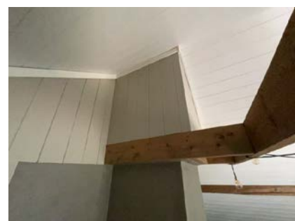
Pipevanger skjult mot takkonstruksjon.
