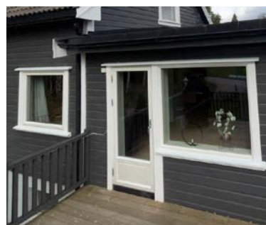
Ytterdør mot underetasje.
