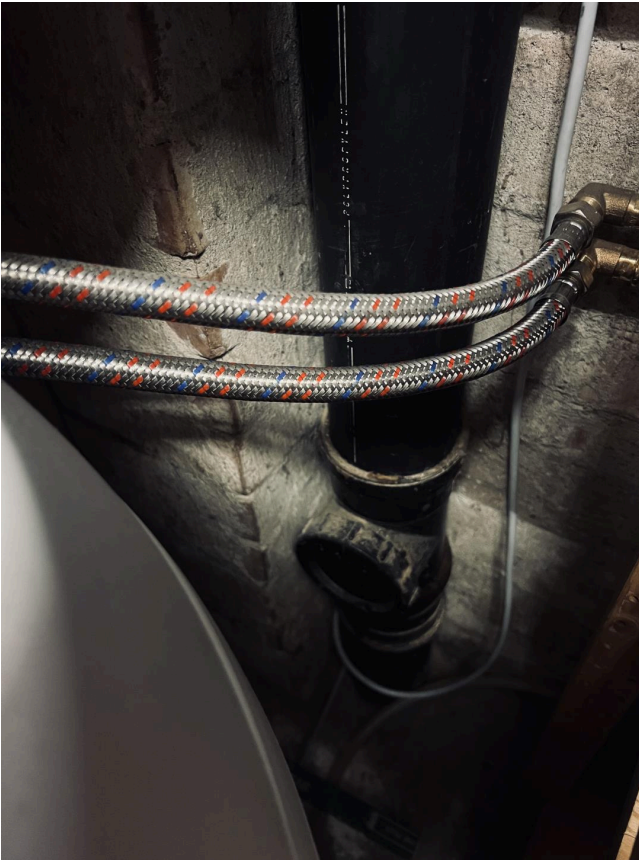
Plast avløps-rør synlig inne i bod.
