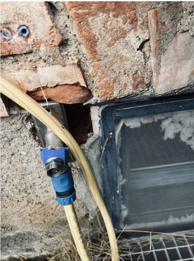
Gjenstående arbeide med gjennomføring for utvendig vannkran.
