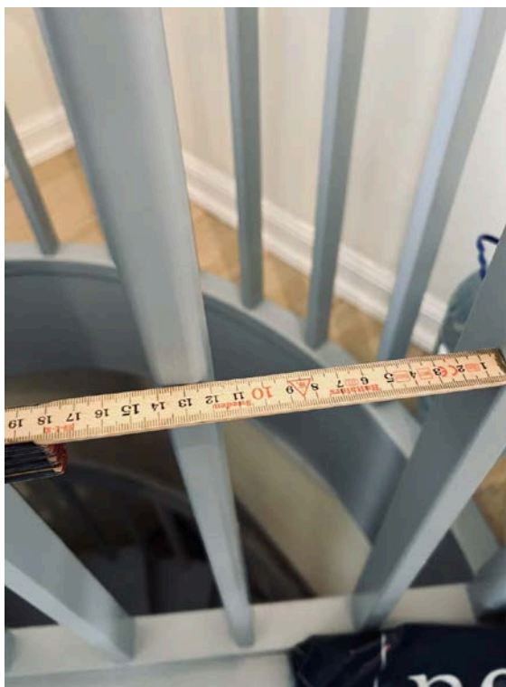
12 cm. åpning i rekkverk. Dette er mer en krav på maks. 10 cm. åpning i et rekkverk.
