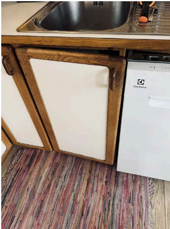
Sterk slitasje på kjøkkeninnredning.
