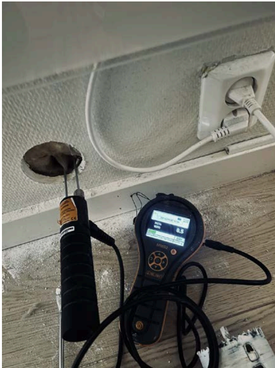
Hulltaking inn mot bad fra gang i kjeller.
