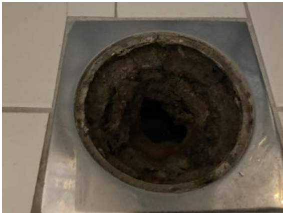
Gammelt støpjernsluk.
