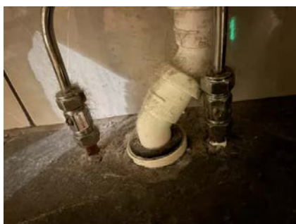
Tetting med mansjett / membran rundt rør bør avsluttet minst 25 mm over ferdig gulv.
