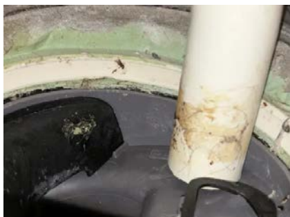
Plastsluk med spor etter membran.
