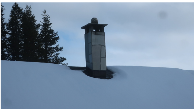
Forblendet pipe over tak.
