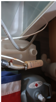
Vannopplegg med kanne og pumpe.
