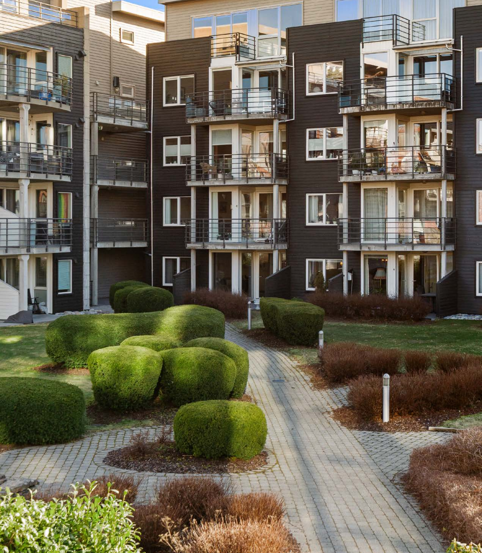
Det er heis og parkering i lukket anlegg under boligblokken
