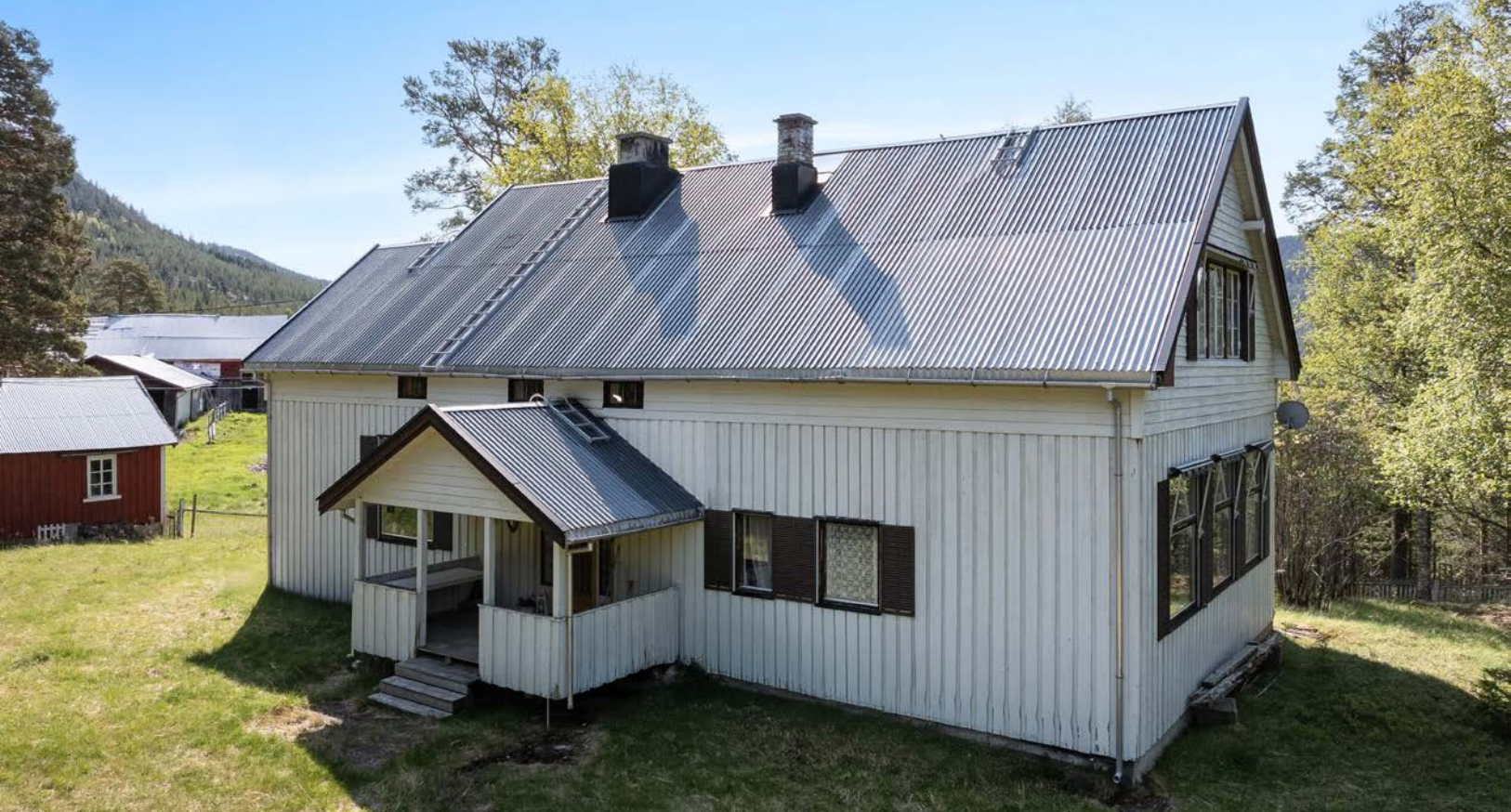
Selve bolighuset som ble oppført i ca. 1926 bærer preg av byggemåten på oppføringstidspunktet. Store rom med høye himlinger er en rød tråd.
