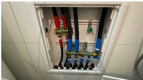
Kontroll av rørfordelingskap.
