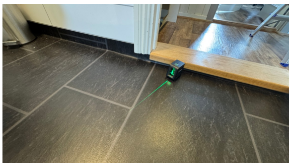
Kontroll av fallforhold.
