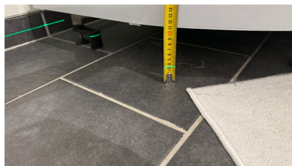
Kontroll av fallforhold.
