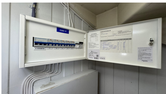
Kontroll av el-skap
