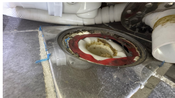
Kontroll av sluk.
