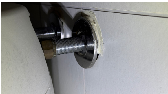
Utett rørgjennomføring.
