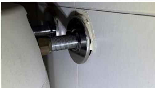
Utett rørgjennomføring.
