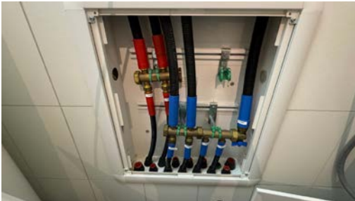
Kontroll av rørfordelerskap.
