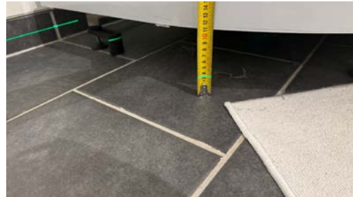
Kontroll av fallforhold.
