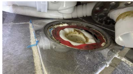
Kontroll av sluk.
