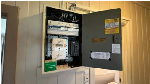
Kontroll av el-skap og kursfortegnelse.
