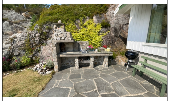
Utekjøkken, tilkoblet vann og gråvann slippes ut på terreng.
