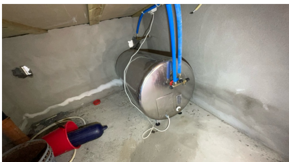
Varmtvannstank.
