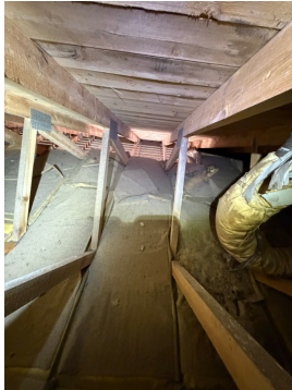
Mangler vindsperre i ende på isolasjon
