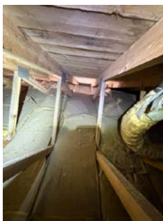
Mangler vindsperre i ende på isolasjon
