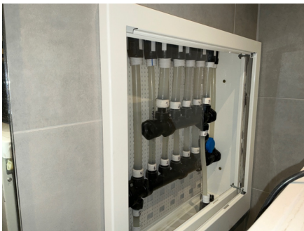
Vanntilførsel er ført til vannfordelerskap avsatt i baderomsvegg i 1. etasje.
